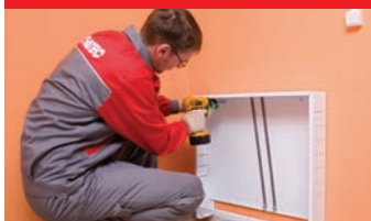
1. Монтаж коллекторного шкафа
