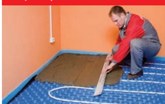
10. Заливка бетонной стяжки с пластификатором
