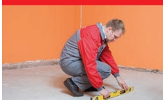
3. Подготовка поверхности пола
