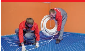
7. Укладка петель теплого пола (металлополимерная труба VALTES)
