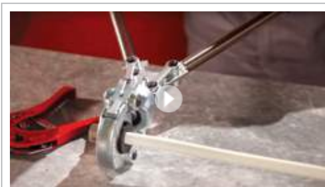
Монтаж металлопластиковых труб.
