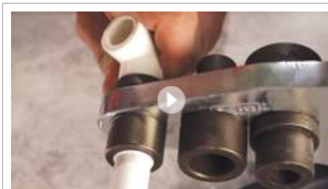
Монтаж полипропиленовых труб.
