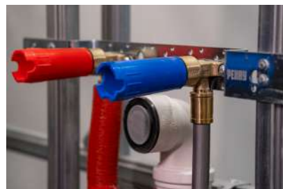
Рис. 07-3 Пример установки – монтажная шина
