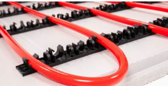
Рис. 80 Крепление труб на арматурной сетке
