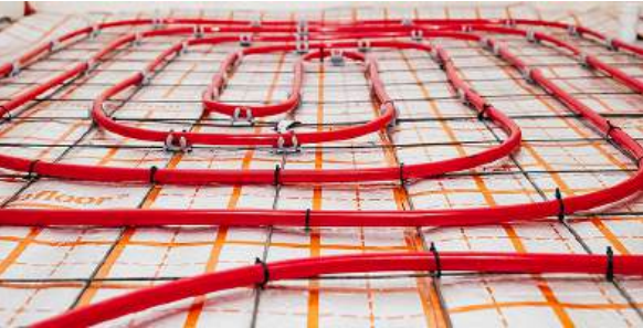
Рис. 78 Крепление труб на фиксирующей шине PEXAY
