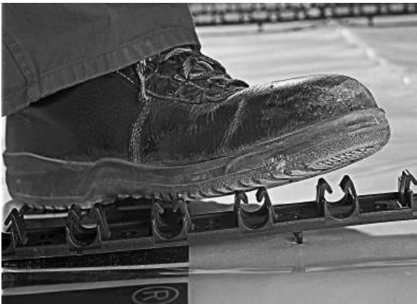
Рис. 94 Вдавливание фиксирующих шин в конструкцию пола
