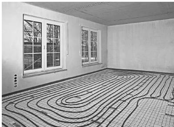
Рис. 87 Система крепления труб с помощью гарпун-скоб
