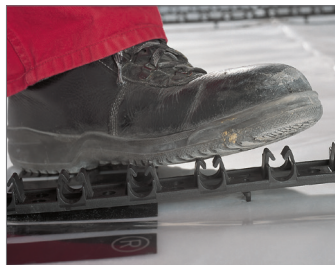
Рис. 15.5-11 Вдавливание фиксирующих шин RAUFIX в конструкцию пола
