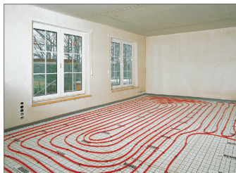
Рис. 15.5-1 Система крепления труб с помощью гарпун-скоб
