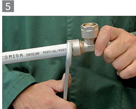
5 TIGHTENING THE JOINT / SERRAGGIO DEL RACCORDO / ANZIEHEN DER VERBINDUNG / SERRAGE DU RACCORD
