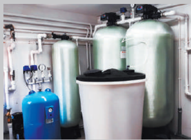
Комплексная станция водоподготовки производительностью 4 м³/ч (механическая очистка, аэрация, обезжелезивание, фильтр с ионообменной загрузкой)
