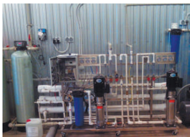
Двухступенчатый обратный осмос производительностью 0,5 м³/ч с предочисткой для подготовки деминерализованной воды для прачечной
