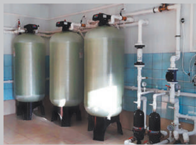
Станция обезжелезивания производительностью 15 м³/ч для рыбоводческой фермы
