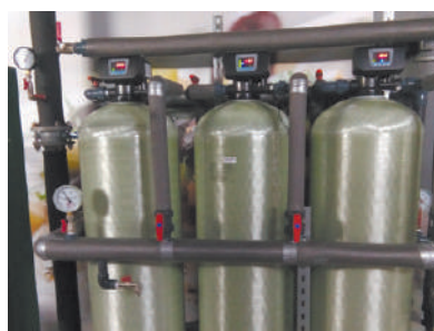
Комплексная станция водоподготовки производительностью 5 м³/ч для пищевого производства (обезжелезивание, удаление нерастворенных примесей, тонкая очистка, УФ-обеззараживание)
